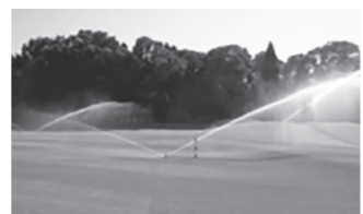
▲ゴルフ場におけるイリゲーション工事（散水設備）
