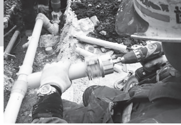
▲建物外部の埋設工事（ガス設備工事）
