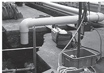
▲土中埋設前のガス導管
