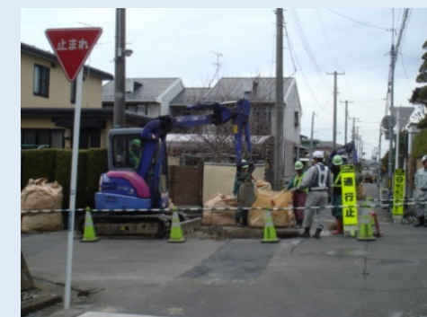
東日本大震災 導管復旧工事
