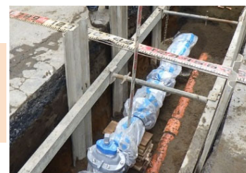
上水道入替工事
