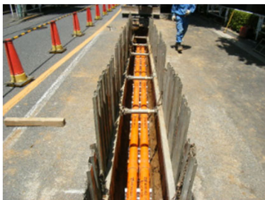
管路地中埋設工事
