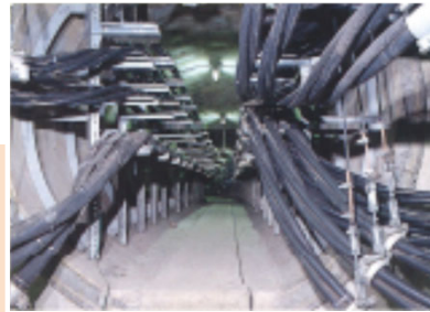
洞道地中建設工事
