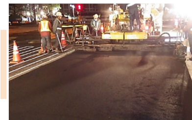
道路舗装工事
