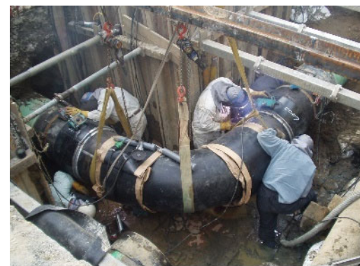
大口径導管溶接工事
