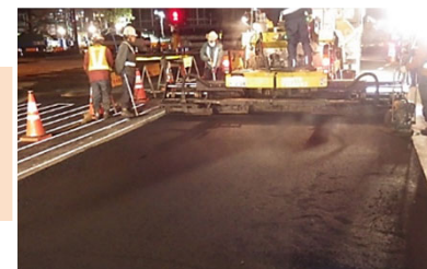
道路舗装工事
