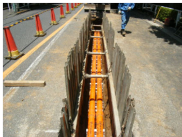
管路地中埋設工事
