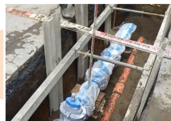
上水道入替工事
