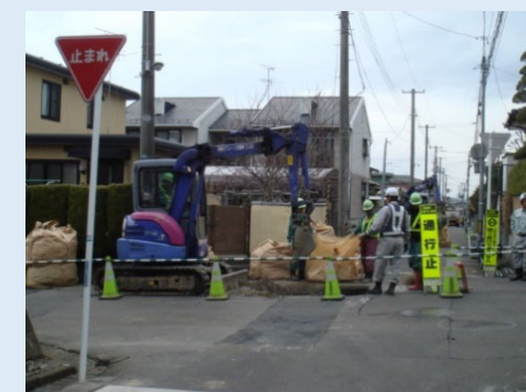
東日本大震災 導管復旧工事
