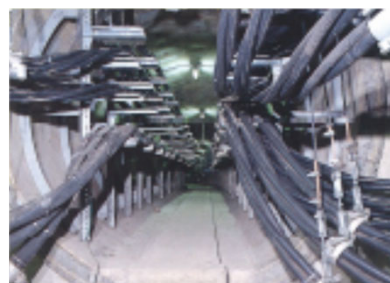
洞道地中建設工事
