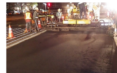
道路舗装工事
