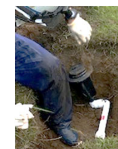
スプリンクラー 取替工事
