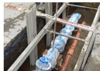
上水道入替工事
