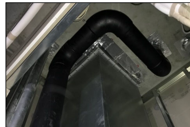
地震等による配管伸縮を抑える可とう配管
