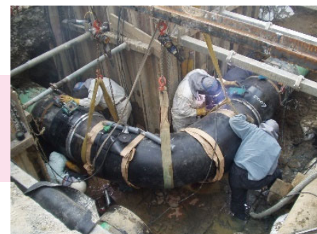
大口径導管溶接工事
