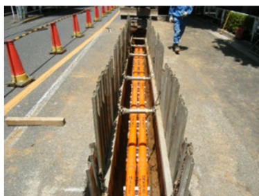
管路地中埋設工事
