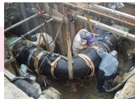
大口径導管溶接工事
