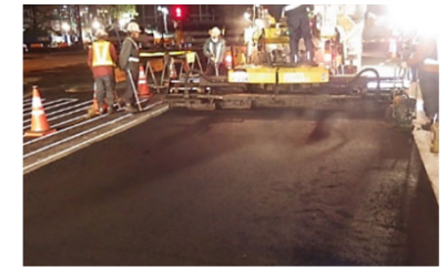
道路舗装工事
