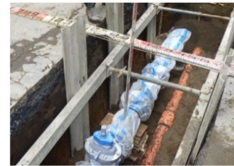
上水道入替工事
