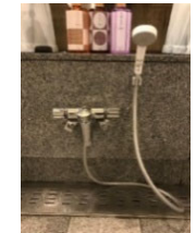
クラブハウス浴室 シャワー水栓取替工事
