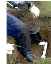
スプリンクラー 取替工事
