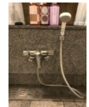
クラブハウス浴室 シャワー水栓取替工事
