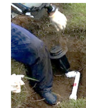
スプリンクラー 取替工事
