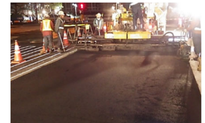
道路舗装工事
