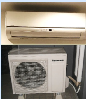
エアコン・室外機
