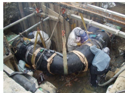
大口径導管溶接工事
