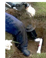
スプリンクラー 取替工事
