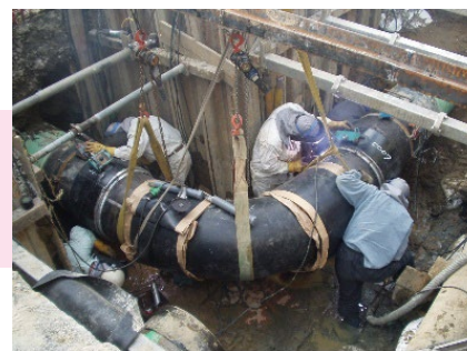
大口径導管溶接工事
