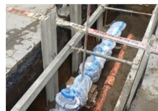
上水道入替工事
