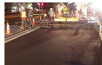
道路舗装工事
