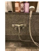
クラブハウス浴室シャワー水栓取替工事
