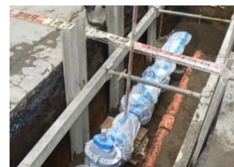
上水道入替工事
