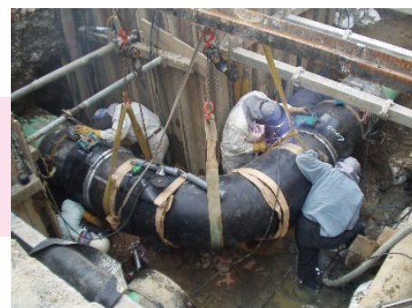
大口徑導管溶接工事
