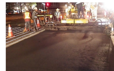
道路舗装工事
