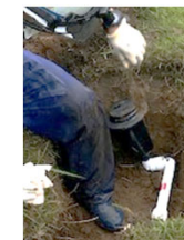
スプリンクラー 取替工事
