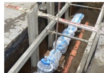
上水道入替工事
