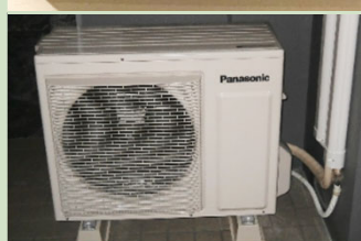
エアコン・室外機
