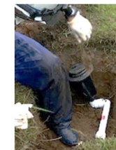
スプリンクラー取替工事
