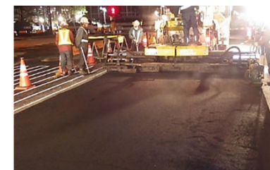
道路舗装工事
