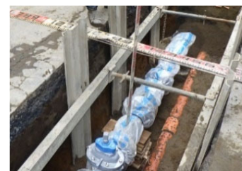
上水道入替工事
