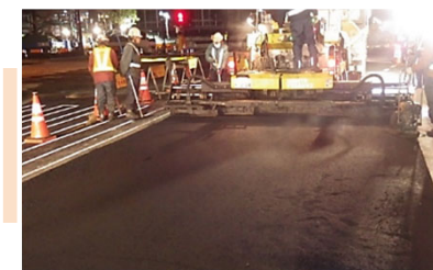
道路舗装工事
