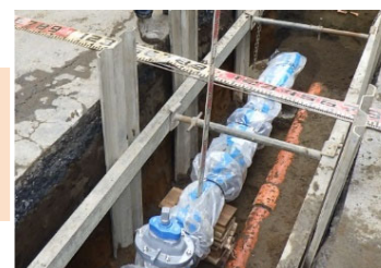
上水道入替工事
