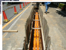
管路地中 埋設工事
