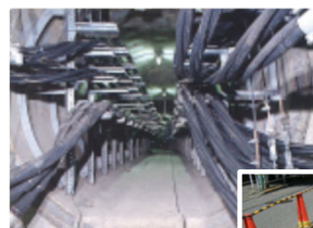
マンホール 地中建設工事
