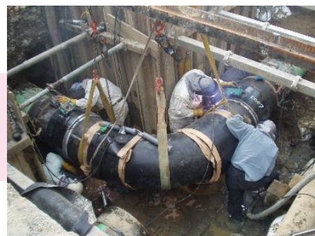
大口径導管溶接工事
