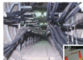
マンホール 地中建設工事
