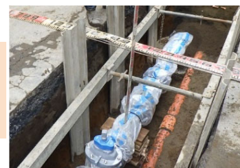
上水道入替工事
