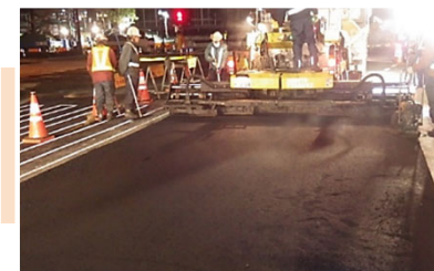
道路舗装工事
