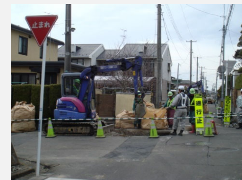
導管復旧工事
