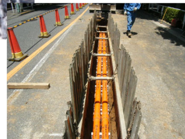
管路地中埋設工事
