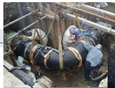
大口径導管 (本管) 工事
