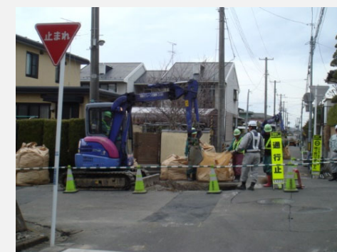
導管復旧工事
