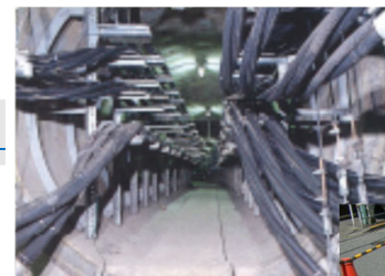
マンホール 地中建設工事
